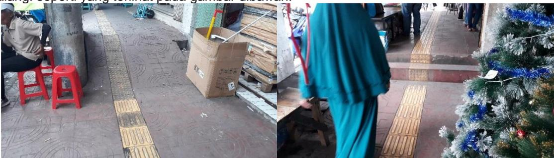
**Gambar 2.** a. Ramp yang Curam, b. Trap Tangga Yang dirasa Tidak perlu
